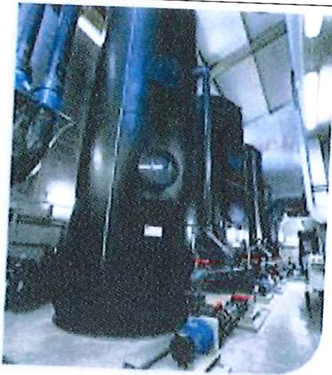
Le traitement de l'air est effectué dans la salle de traitement des odeurs qui fait partie de la station.
